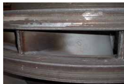
Girante Francis - Ripristino con Riporto in Inox 13/4 (Dettaglio) Francis Runner - Regeneration Inox 13/4 Overlay (Detail)
