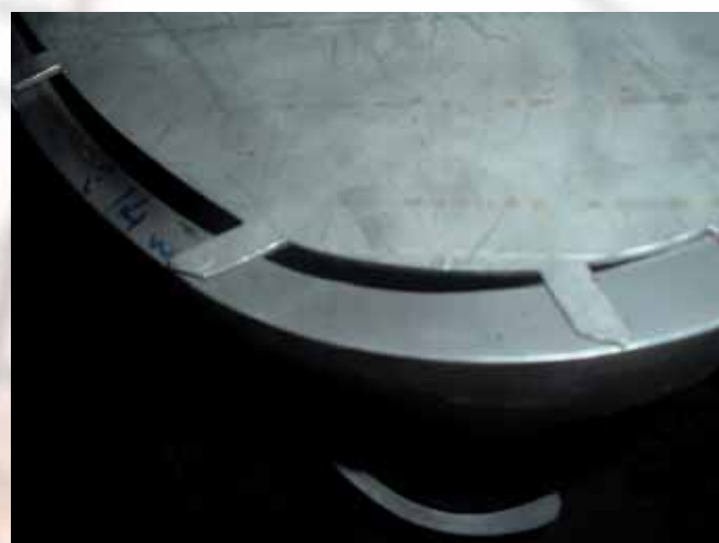
Dettaglio Erosione Interno Pala Inside Bucket Erosion Detail
